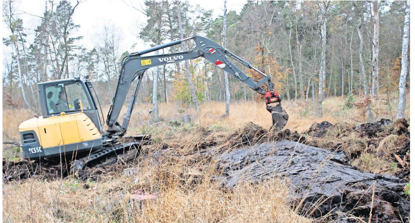
Karsten Behrend von der Erd- und Landschaftsbau GmbH Schmitz aus Pentz bei der Arbeit mit seinem Bagger im Gresenhorster Teufelsmoor. An rund 50 Stellen werden die alten Entwässerungsgräben mit Torf verfüllt. Dies ist ein wichtiger Schritt zur Wiedervernässung des Moores. FOTOS: EDWIN STERNKIKER
